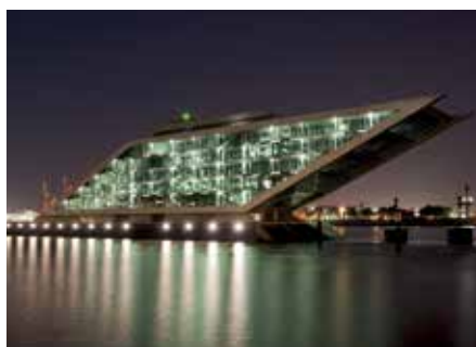
Bezpieczeństwo przeciwpożarowe budynków
