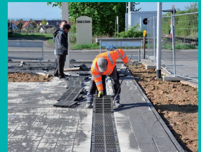
5. Zamknięcie rusztów za pomocą systemu SIDE-LOCK (z dodatkową możliwością wykorzystania śrub).
