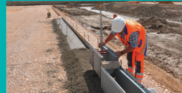
1. Instalacja betonowych koryt FASERFIX®SUPER.
