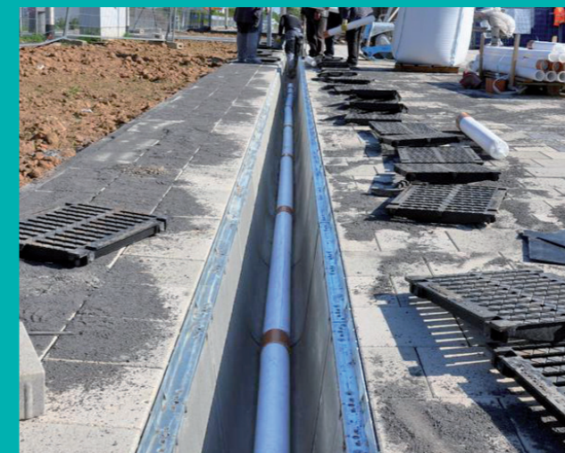
2. Ułożenie rur odpływowych w zamontowanych już korytach FASERFIX®SUPER.
