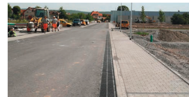
Zabudowa w nawierzchni asfaltowej.
