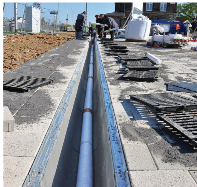
Koryta DRAINFIX®CLEAN podczas montażu.
