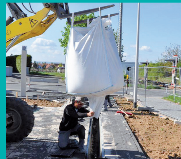
3. Wypełnienie koryt substratem CARBOTEC®60.
