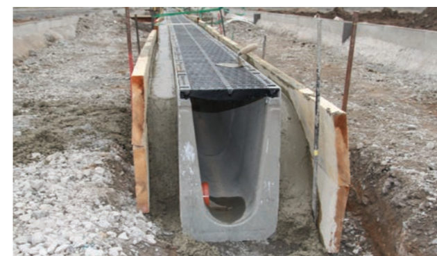
1. Montaż koryt DRAINFIX®CLEAN.
