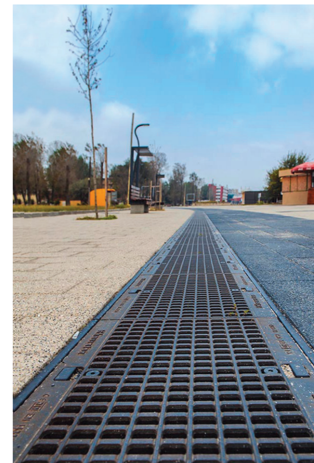
Bulwary nadmorskie, Mamaia, Rumunia
