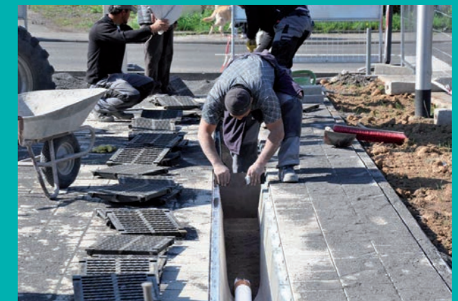
4. Wyrównanie warstwy substratu CARBOTEC®60 na odpowiednią wysokość.
