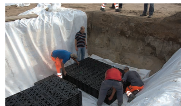
2. Montaż systemów rozsączających np. DRAINFIX®BLOC.
