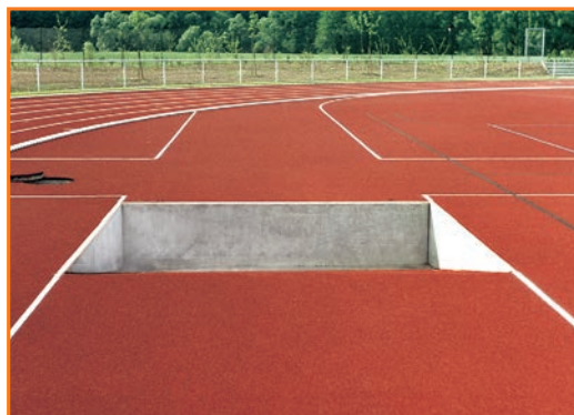
Betonowy rów z wodą zgodny z wymogami IAAF.
