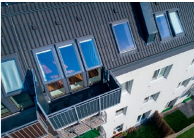
Budynki wielorodzinne, Wrocław
