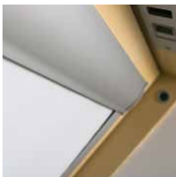
Listwa aluminiowa kryjąca wałek rolety
