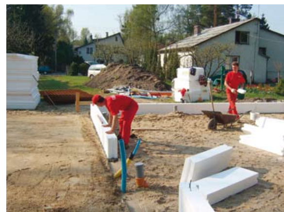
Wyznaczamy zewnętrzny obrys fundamentu. Po wyprowadzeniu przyłączy kanalizacyjnych ustawiamy styropianowe elementy brzegowe, tworzące całość budynku i jego izolację.
